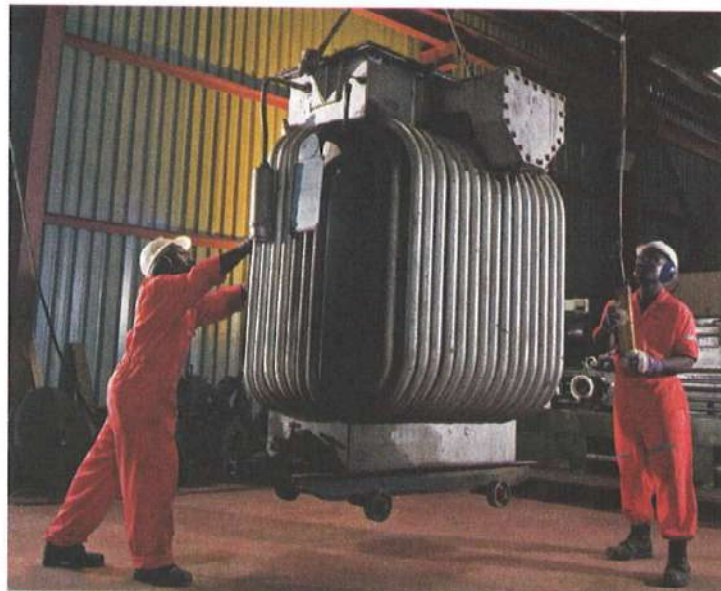
Figura 17.14 Instalimi i një transformatori të ri.
