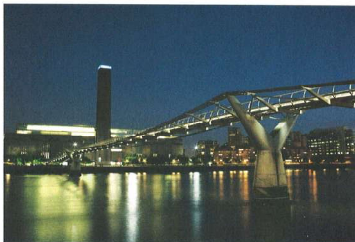
Figura 18.29 Ura Millennium Footbridge në Londër u mbyll për rreth dy vjet, për të korrigjuar problemet e shkaktuara nga rezonanca.
