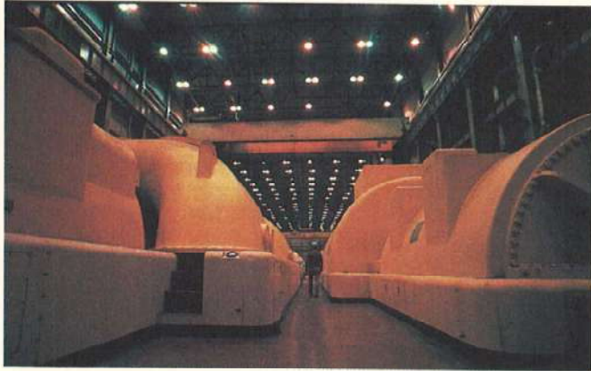
Figura 16.15 Gjeneratorët e këtij centrali elektrik prodhojnë elektricitet me f.e.m. 25kV. Për pyetjen 6.
