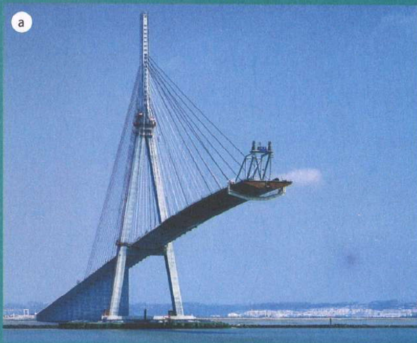
Figura 21.1 a Një urë e varur në ndërtim e sipër. b Një urë që u shkatërrua: ura e Ngushticës së Takomës.
